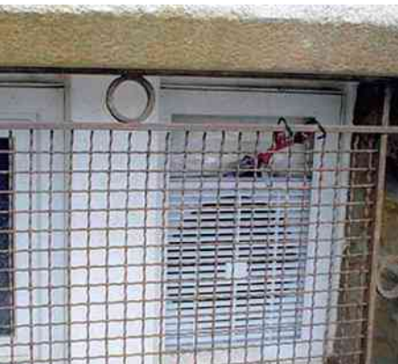
Mit einem kleinen Ventilator wird im Kellergeschoss oder Kriechkeller ein Unterdruck gegenüber dem Wohnbereich erzeugt.
