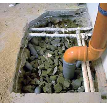
Mit einem kleinen Ventilator wird im Kellergeschoss oder Kriechkeller ein Unterdruck gegenüber dem Wohnbereich erzeugt.
