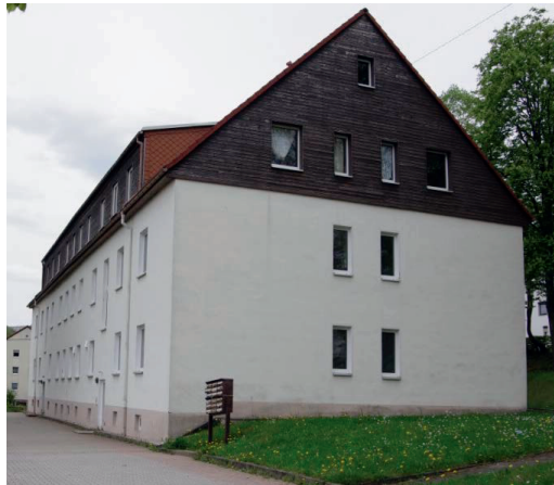
Abb. 1: Leergezogener Wohnblock als Versuchsort zur Durchführung von Lüftungsversuchen zur Senkung der Radonaktivitätskonzentration mit Lüftungsgeräten iV14-Zero und drahtloser Aktivierung des Reglers MZ-Home durch einen Radonmonitor Radon Scout Plus
